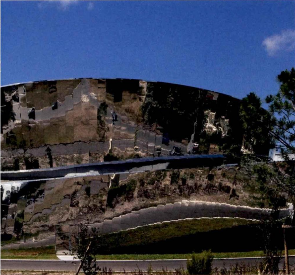
Ces objectifs ont conduit à utiliser, sur les chambres du R+1 au R+4, des châssis Wiclina 65 conçus par Wicona en configuration fixe, exception faite des ouvrants pompiers. L'usage de dormants de la version ouvrant caché permet de les équiper de vitrages épais de qualité Silence et faisant garde-corps à certains endroits
